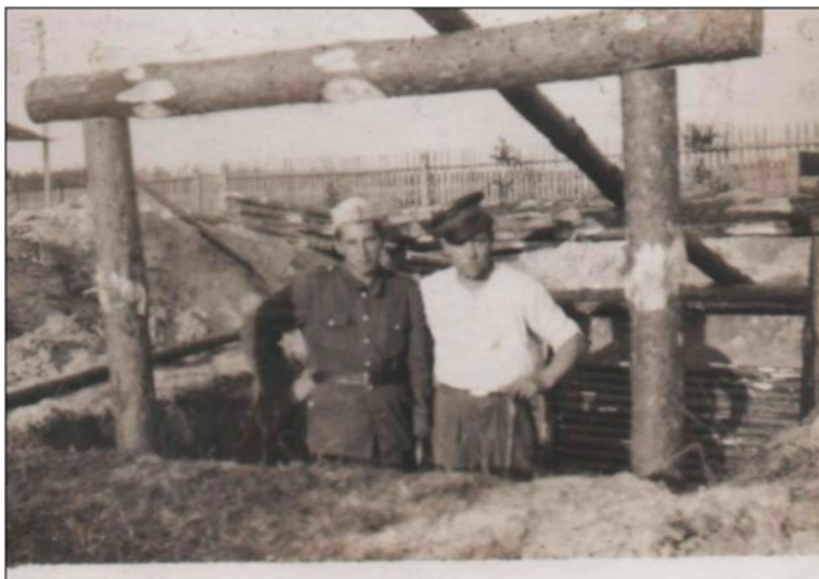
Budowa ziemianki – Masiewo 1946 r.
