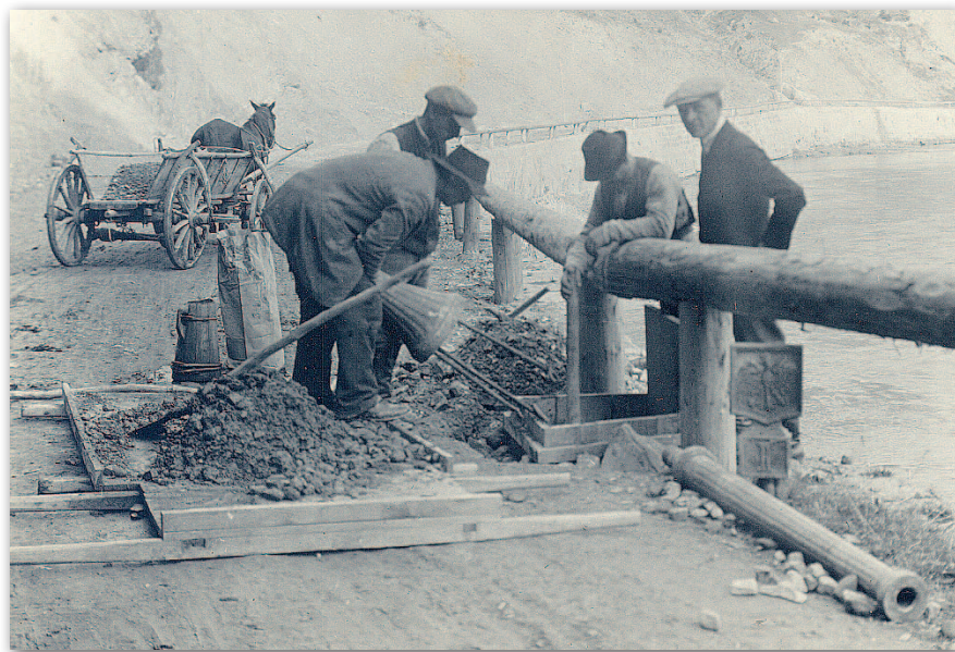
7. Osadzanie stopy słupa głównego w wykopie fundamentowym nad brzegiem Czeremoszu na odcinku sekcji II w 1929 r. Jego głowica i trzon leżą jeszcze niezmontowane. Fot. ze zbiorów prof. A. Linsenbartha
