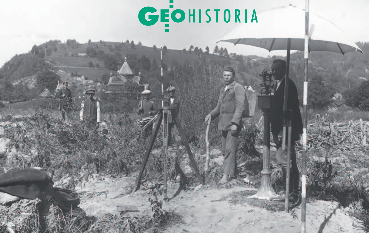
1. Pomiar kątów na odcinku nr 22 sekcji II w Roztokach nad Czeremoszem w 1929 r. Na słupku pośrednim ustawiony teodolit. Koło cerkwi widoczny sygnał triangulacyjny (za plecami strażnika granicznego). Fot. Koncern IKC [NAC, sygn. 1-H-536-1]
