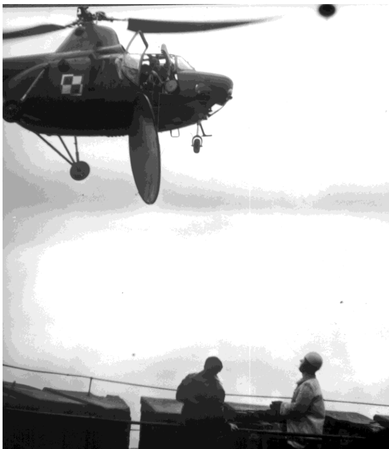
Śmigłowiec SM-1 podczas montażu anteny na zamku w Człuchowie.
