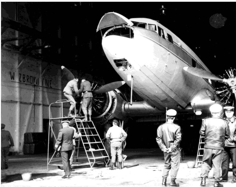
Prace obsługowe wykonywane przez personel eskadry na samolocie transportowym Li-2.
