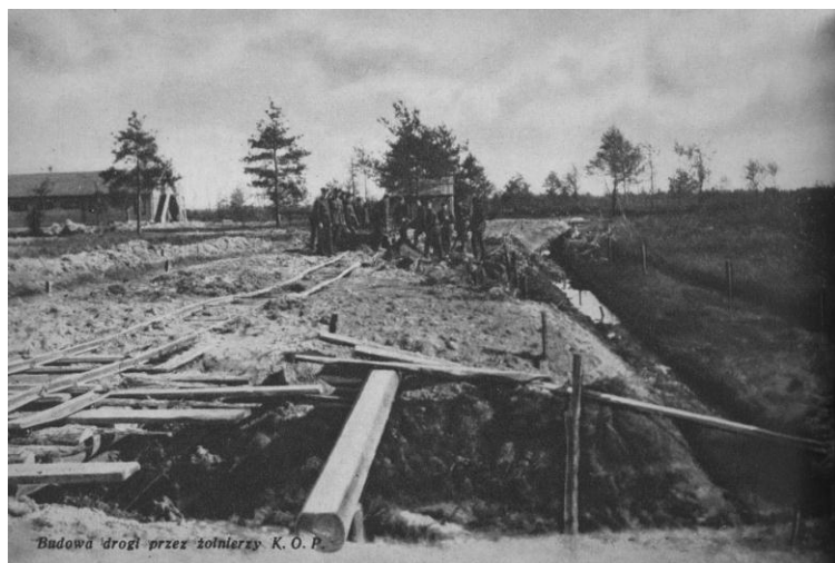
Budowa drogi przez żołnierzy KOP
