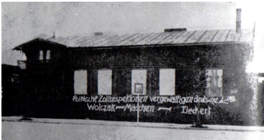
Dom mieszkalny inspektorów placówki terenowej w Kałdowie, który był przedmiotem wcześniejszych ataków tzw. nierozpoznanych sprawców, po spaleniu i dewastacji wewnątrz, z charakterystycznym napisem jakimi w tym dniu „dekorowano” wiele miejsc w Kałdowie, przestał służyć inspektorom celnym.
