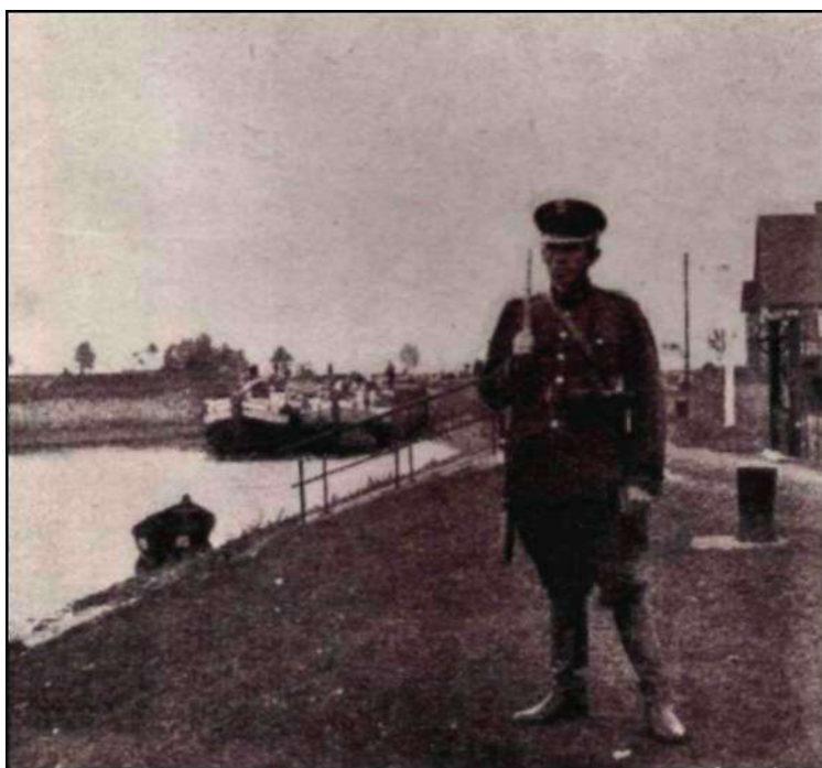
Nadzór nad transportem wodnym na Noteci – Komisariat Ujście (źródło: Czaty, Nr 21 – 22, z dn. 11.11.1933 r. , s. 31)
