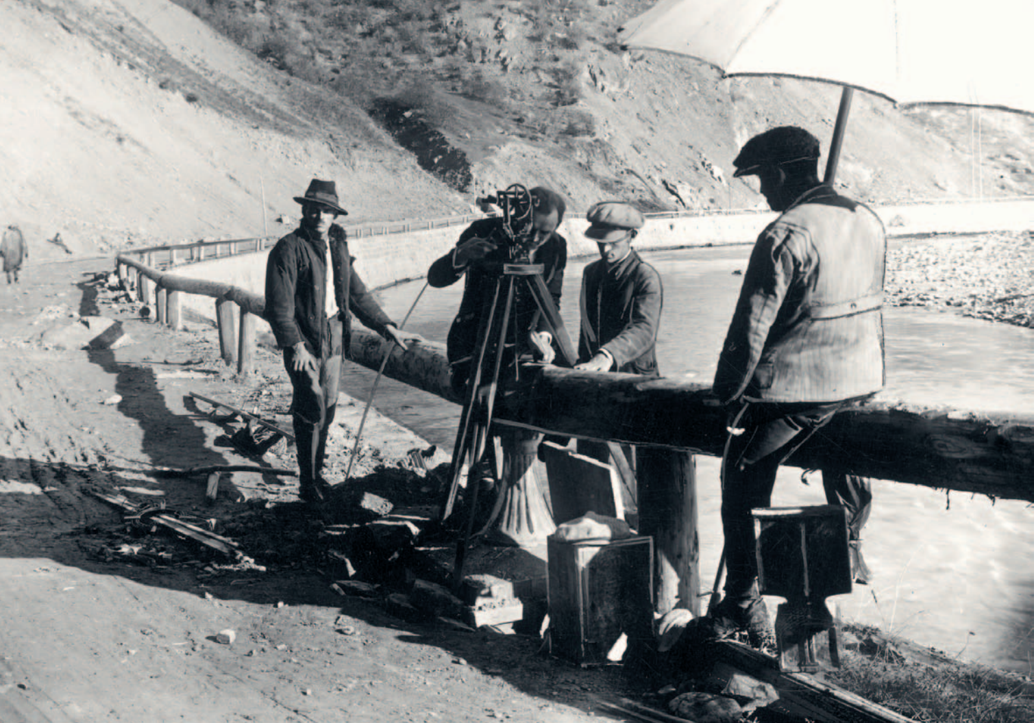
1. Pomiar kątów w sekcji II w zakolu Czeremoszu w 1929 r. Teodolit na statywie ustawionym nad zabetonowaną stopą słupa głównego, którego głowica i trzon leżą niezmontowane. Fot. Koncern IKC [NAC, sygn. 1-H-536-8]
