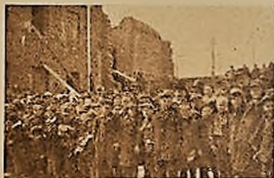
Działwa przed będącą w budowie szkołą im. gen. Jur-Gorzechowskiego w Rajgradzie
