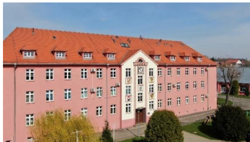
Budynek nr 5, w którym znajdują się Zakład Kynologii i Zakład Ogólnozawodowy
