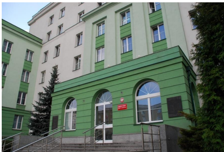
Fot. 11. Front budynku Komendy Głównej Straży Granicznej przy al. Niepodległości 100 w Warszawie – źródło: zasoby własne SG
