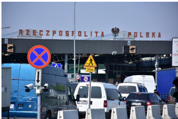
Fot. 1. Drogowe przejście graniczne w Medyce
