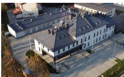
Fot. 34. Siedziba Placówki SG w Tarnobrzegu; fot. Dawid Gajda
