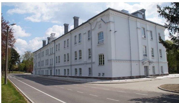
Fot. 22. Wyremontowany budynek nr 2 w Komendzie Oddziału
