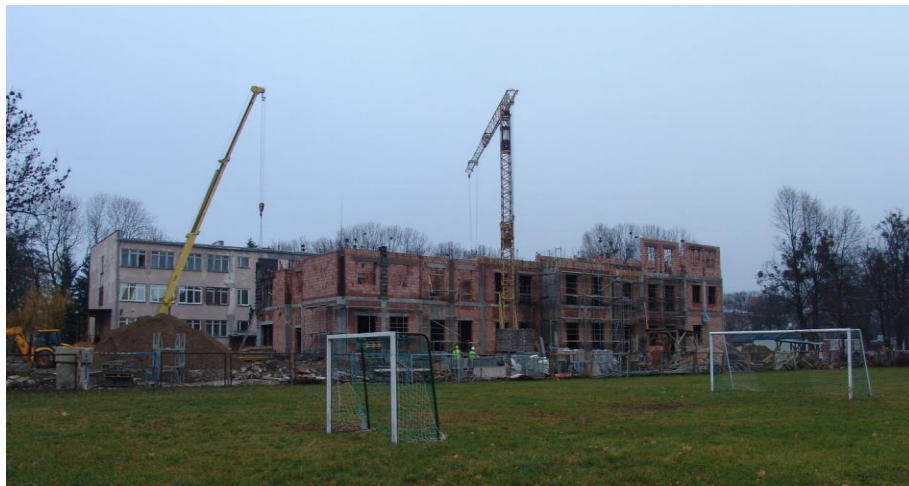
Fot. 7. Budowa budynku nr 1 w komendzie NOSG – ze zbiorów NOSG
