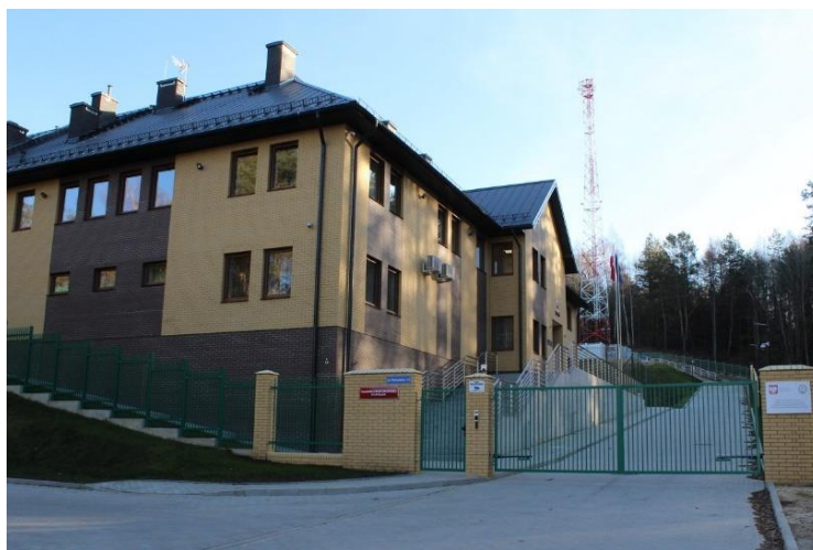
Fot. 21. Nowy obiekt Placówki SG w Krynkach
