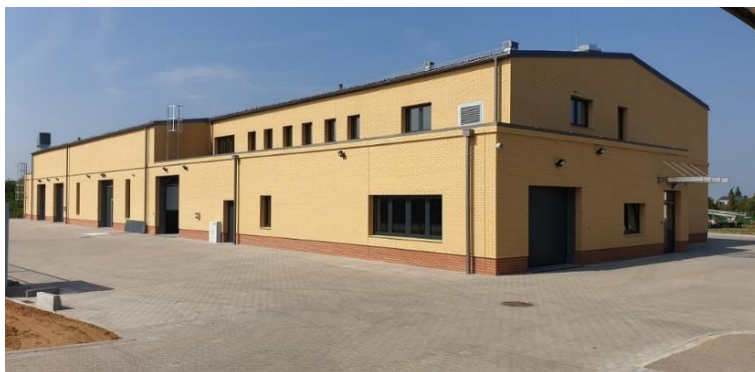
Fot. 23. Stacja obsługi pojazdów w Komendzie Oddziału
