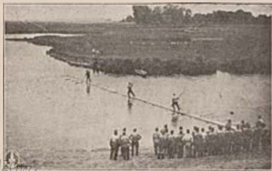
Budowa kładki na Horyniu przez pluton pionierów K. O. P.
