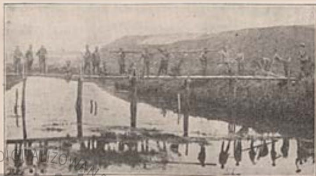
Budowa kładki we wsi Babin na rzece Korczyk
