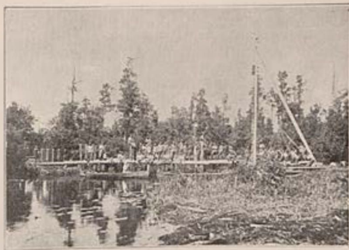
Budowa mostu na rzece Łani
