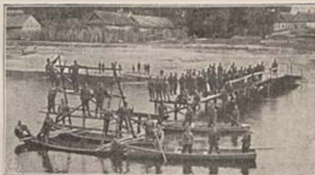
Budowa lekkiego mostu. Dawidgródek
