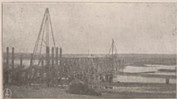
Wbijanie pali przy budowie mostu
