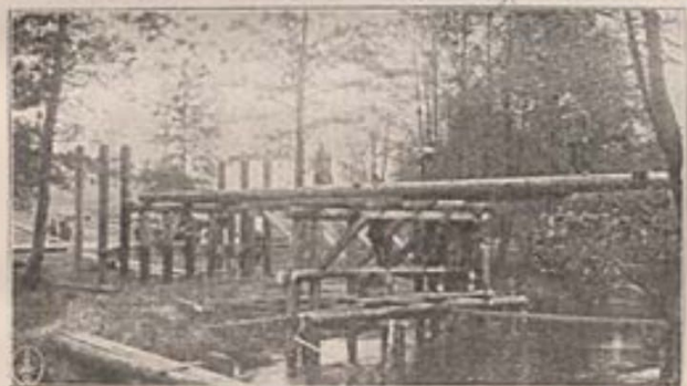
Rozpoczęcie budowy mostu na rzece Uła
