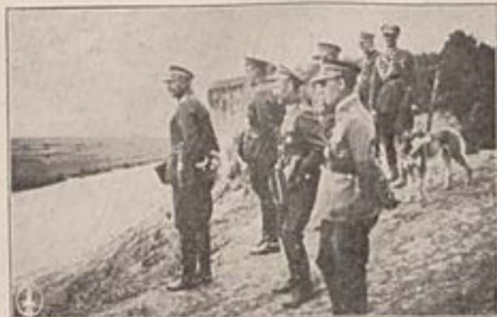
D-ca K. O. P. gen. Minkiewicz przypatruje się budowie kładki
