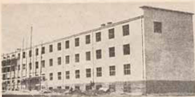
Budowa koszar w Stolpach
