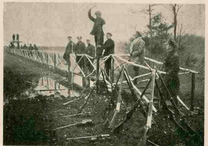
Budowa kładki patrolowej na odcinku 9 baonu
