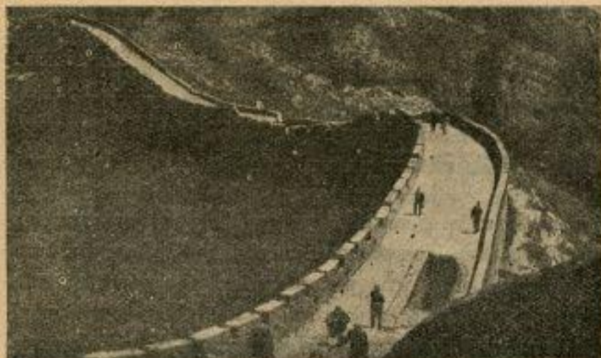
Wielki Mur wspina się na wysokie góry...
