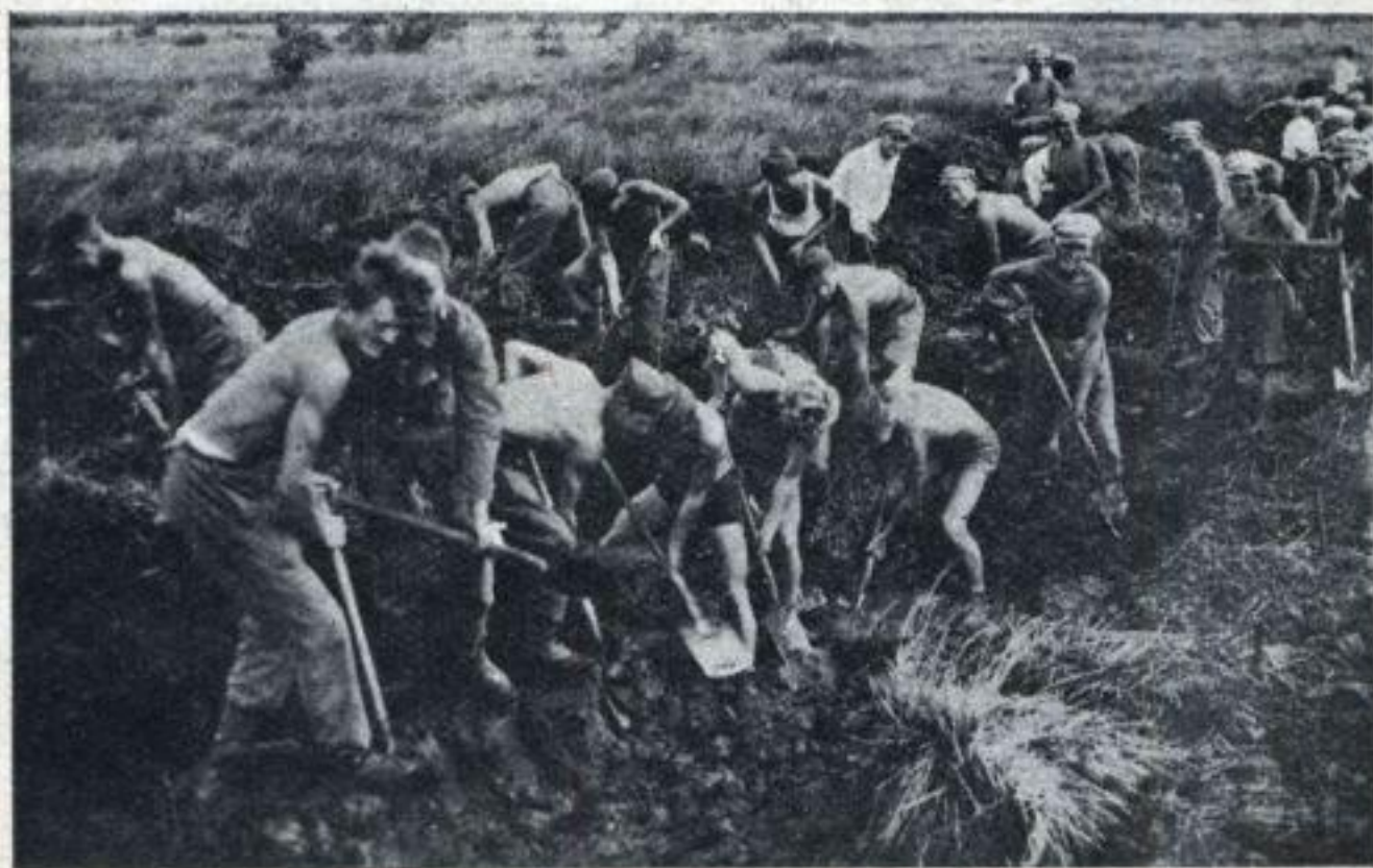
Walka z bagnistym gruntem. (Brześć n/Bugiem).
