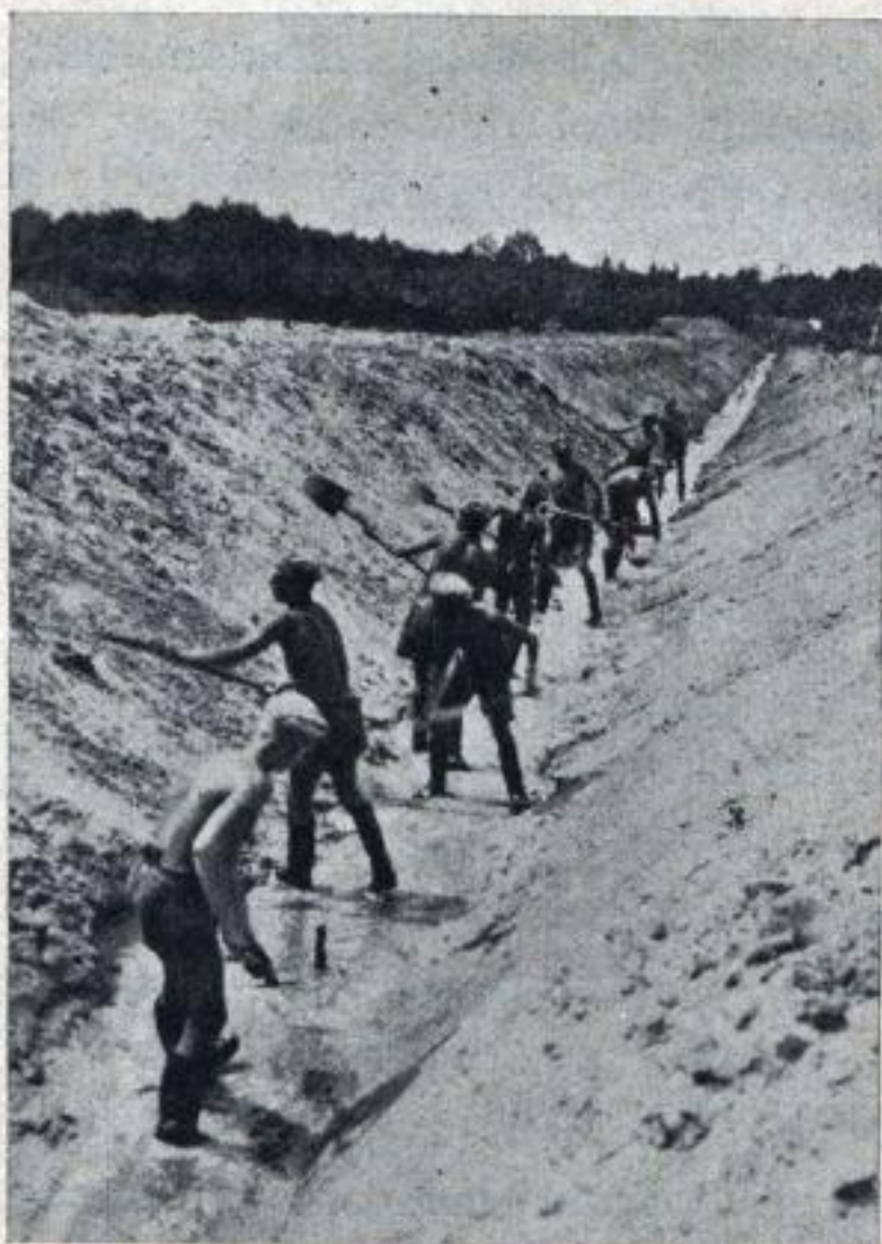
Junacy kopią rów odwadniający w Brześciu n/Bugiem.
