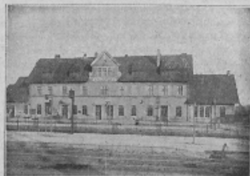
Dziadowo. Dworzec kolejowy.
