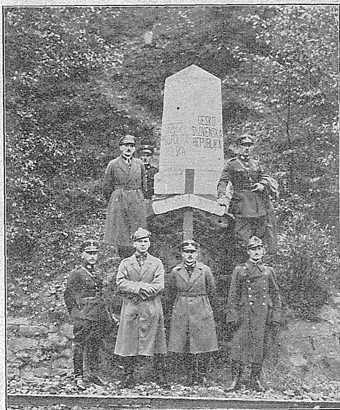
Na odcinku plac. Zwardoń.
