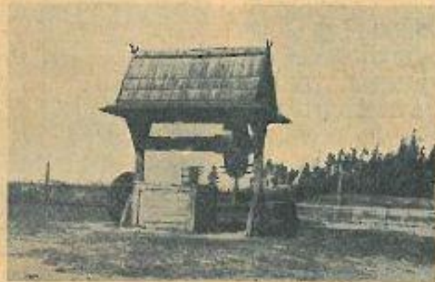
Studnia przy strażnicy KOP
